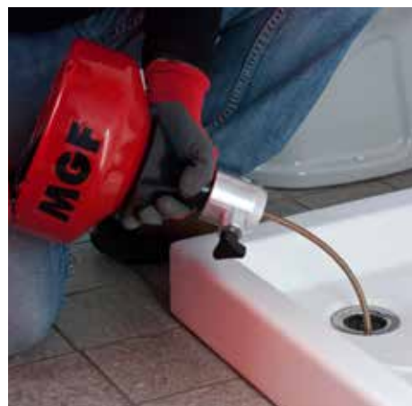
Esempio disostruzione doccia
