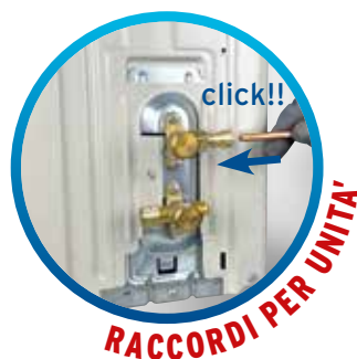
1 SERRAGGIO RACCORDO UNITÀ
