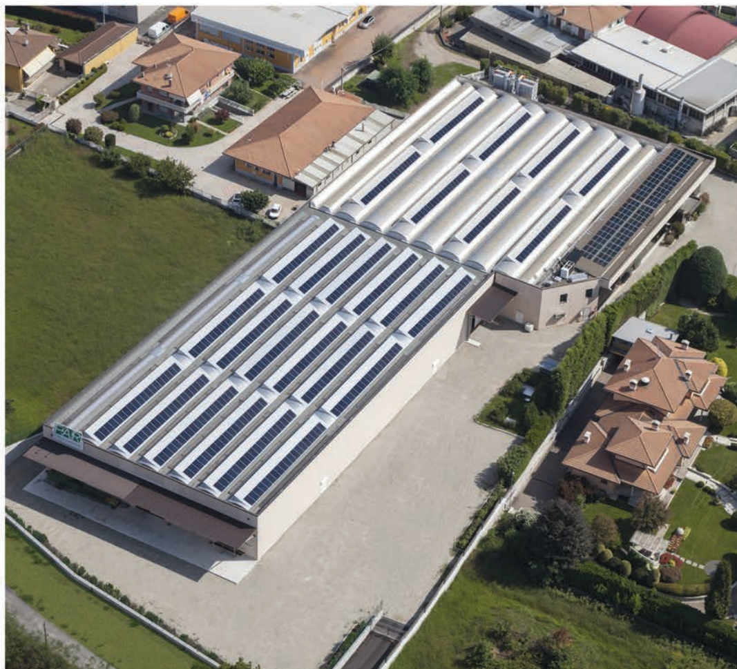
◀ Stabilimento FAR 2 Gozzano (NO) Torneria - Magazzino
