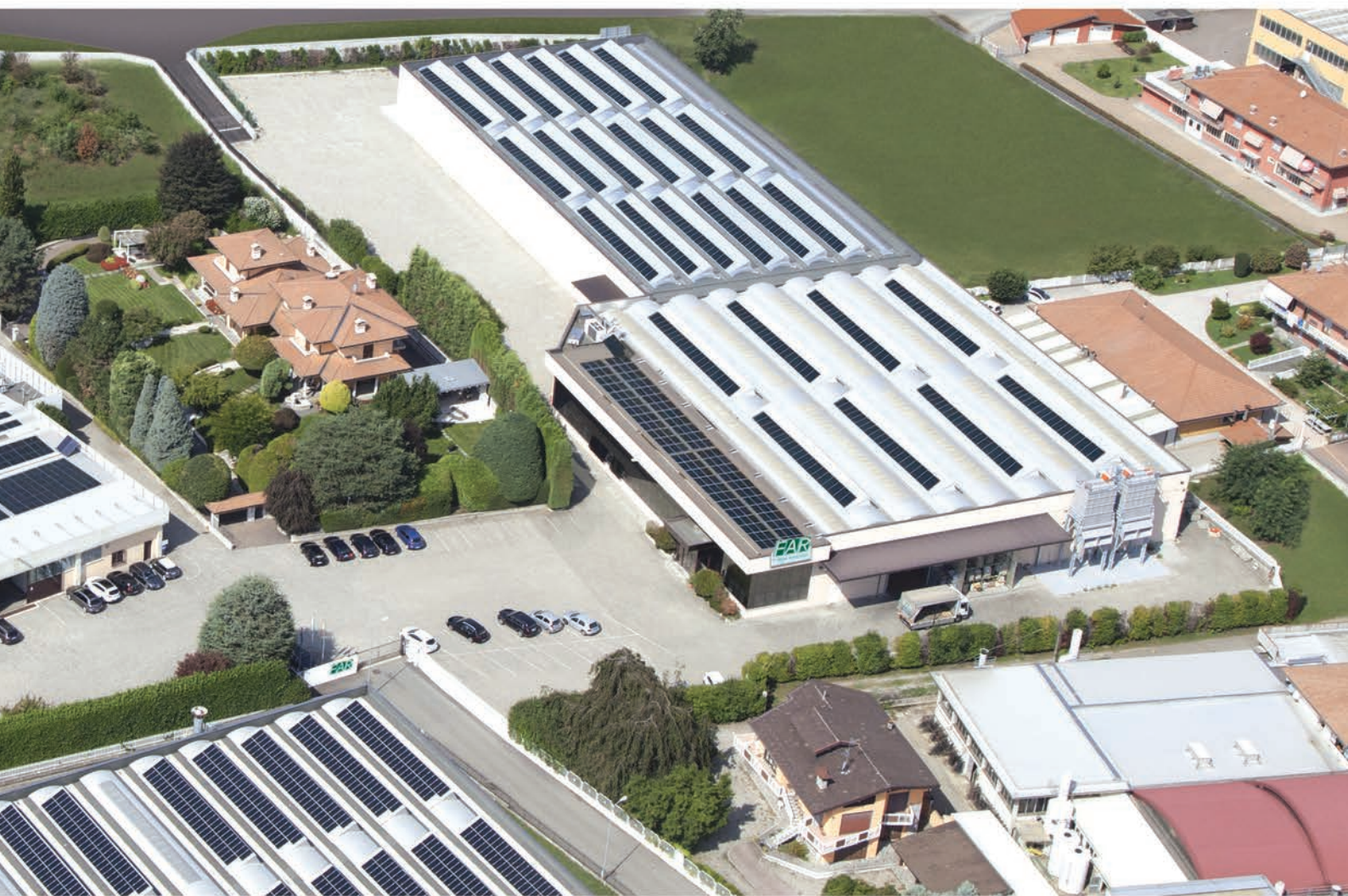
▲ FAR Gozzano (NO) Sede principale Produzione - Magazzino - Uffici
