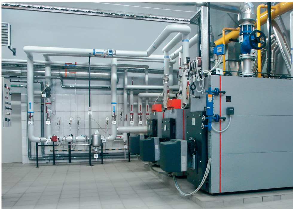
Applicazione tipica in una piccola impresa: qui una Vitomax LS (davanti) collegata a due caldaie Vitocrossal
