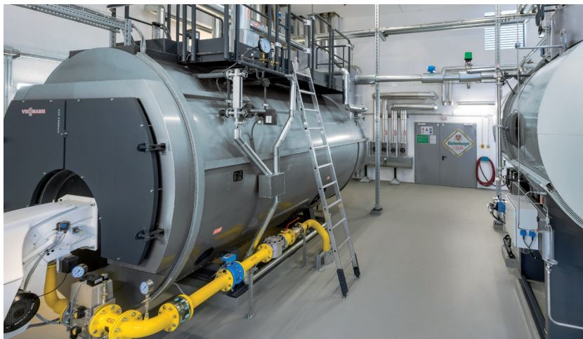
Vitomax HS con una portata di vapore di 6 t/h e una pressione di 10 bar
