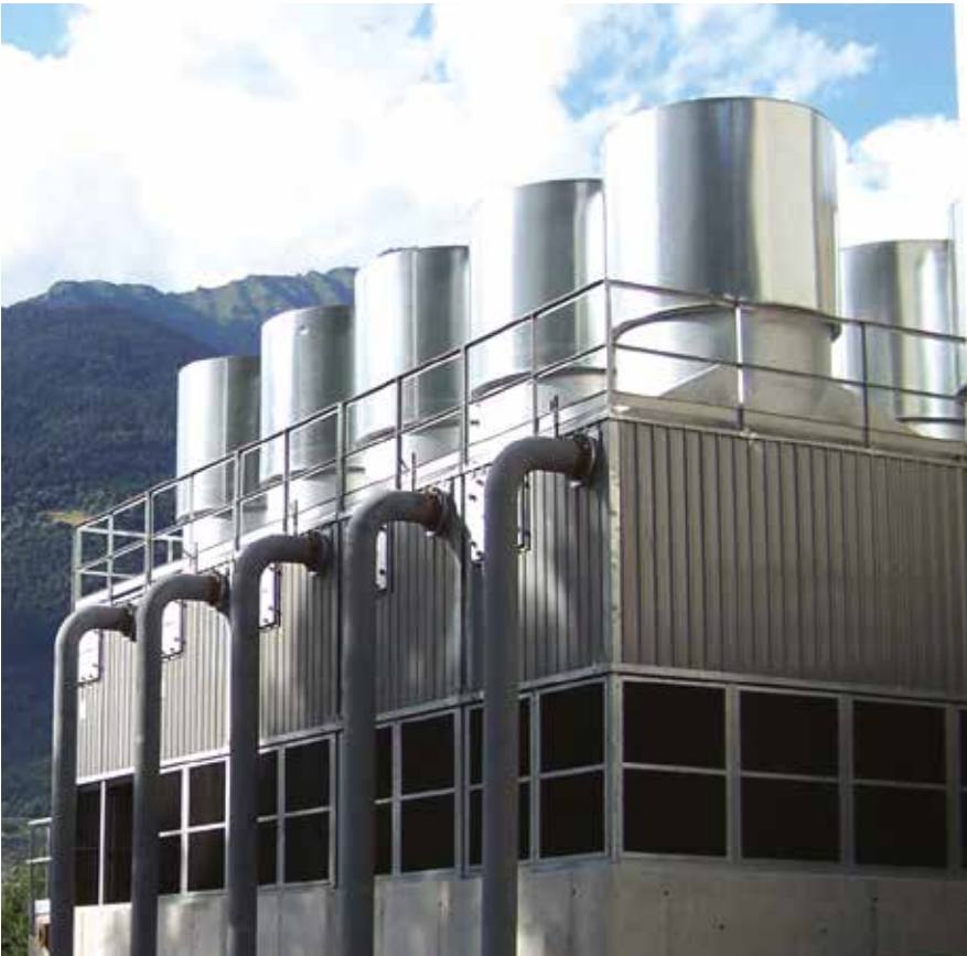
SILENZIATORI MCTA in alluminio per torri evaporative
